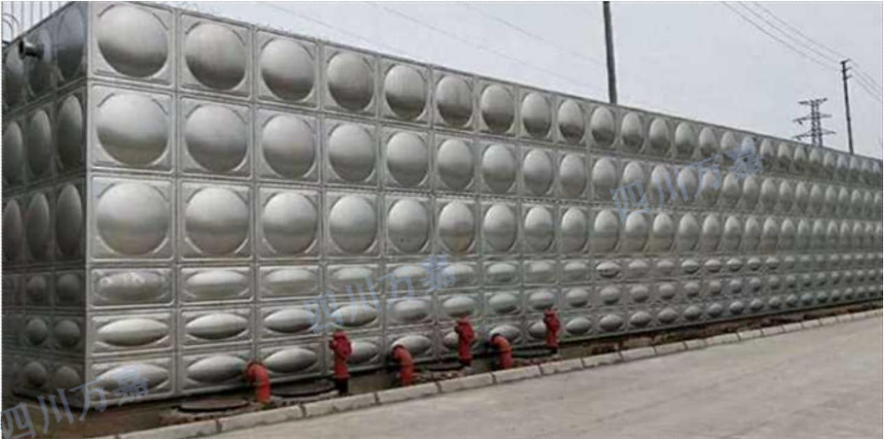
不锈钢复合埋地水箱是用不锈钢/镀锌双金属复合板，经冲压拉伸成型的复合水箱模板，不锈钢复合板保证了水质的卫生，镀锌板水箱的机械强度。整块模板没有焊接部分接触水，从而使水质清洁，也杜绝了对水箱板的腐蚀，是制造装配式水箱的好材料。使用及维护不需焊接，螺栓链接，简单，快捷，方便。新型不锈钢复合板采用不锈钢为面板，热镀锌板，基板，经过物理机械加工，由高分子树脂聚合物胶粘而成。此外，新型不锈钢复合板采用较薄的不锈钢为面板，在复合板中所占比例较低，从而节约了贵金属的使用，同时具有不锈钢，有色金属及碳钢的优点，增加了材料的使用年限。因此新型不锈钢复合板是一种绿色节能材料。不锈钢复合板采用sus304为面板，因此产品具有良好耐蚀性，耐热性，低温强度和机械性能，同时不锈钢表面可加工镜面，蚀刻等，使得产品具有装饰性，豪华性。不锈钢复合板镀锌板的性能，具有很高的延伸率，容易加工成型，如切割，冲压，折弯等。在日益激烈的市场竞争环境下，成本优点将在企业保持自身竞争中占据主导地位。不锈钢复合板采用sus304和碳素钢为原材料。
